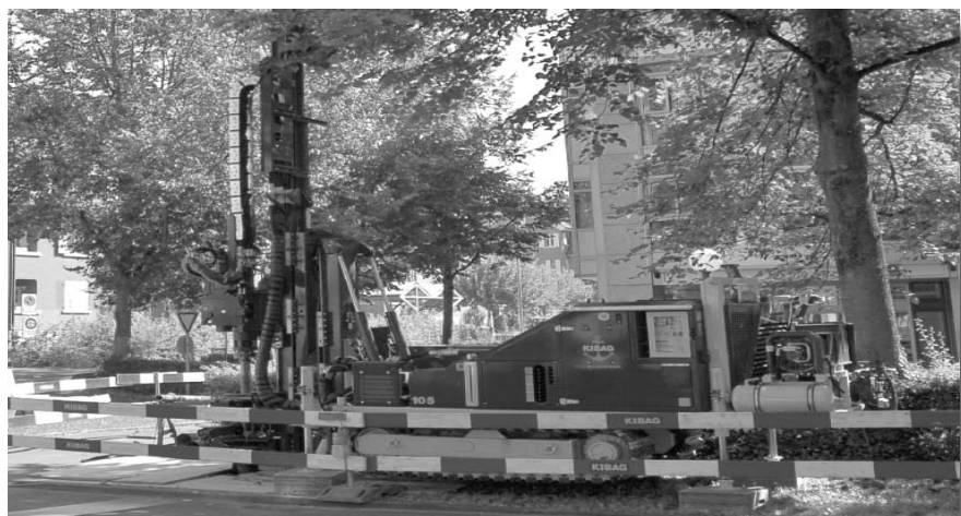
Bohrung im Bereich des geplanten Portals Gubelstrasse
