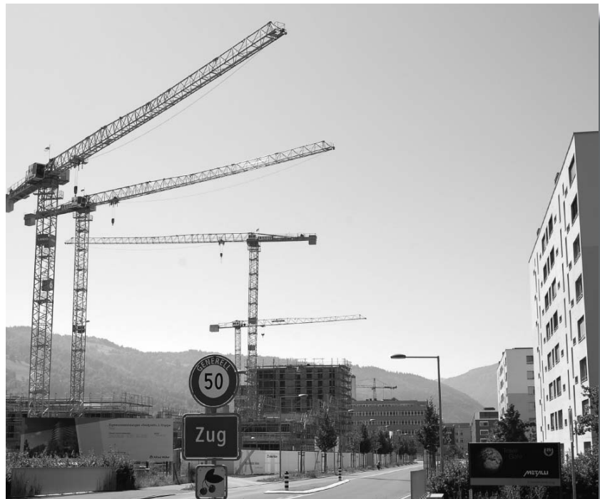
Grossbaustellen in „Zug-West“
